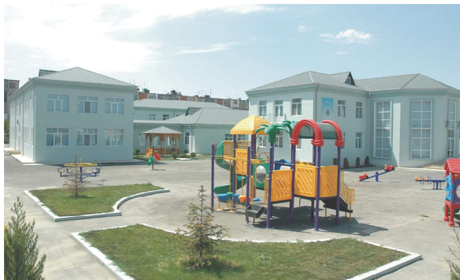
Bakı şəhəri, Binə kənd uşaq bağçası
